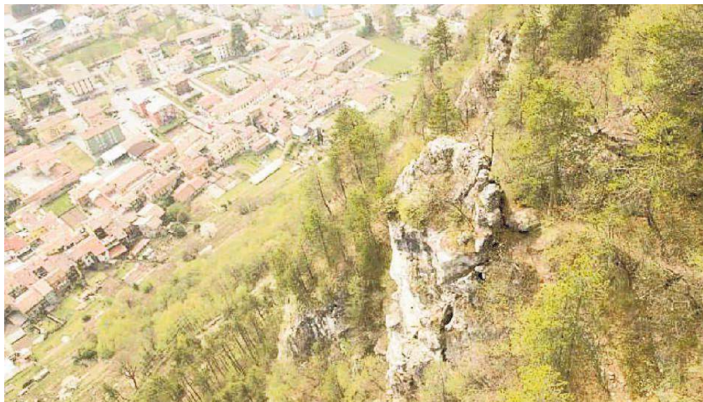
Il diedro pericolante sopra via Teatro: le operazioni di brillamento verranno effettuate a fine agosto
